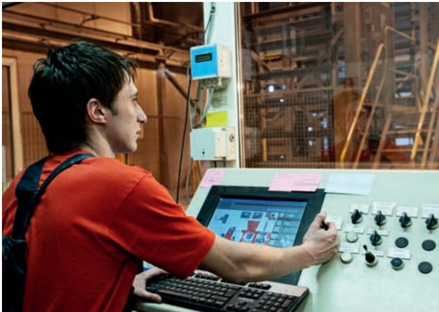
Maschinensprache verstehen: Dafür müssen auch die Bedienpulte entsprechend angepasst werden.
